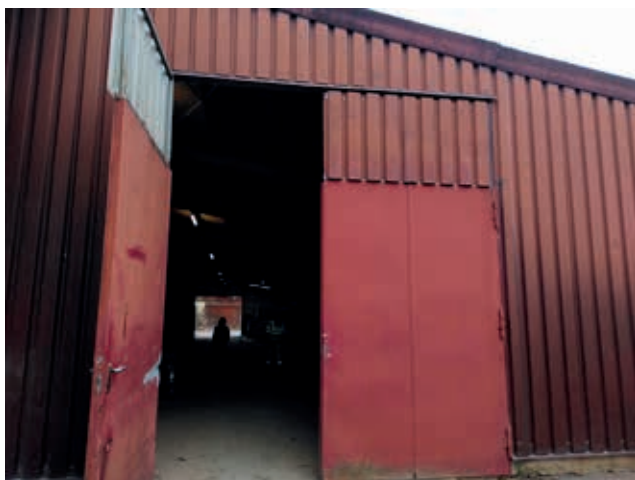
Das Tor der Blechhalle ist nach oben vergrößert, damit die großen Maschinen für den Landschaftsbau in die Halle passen.
