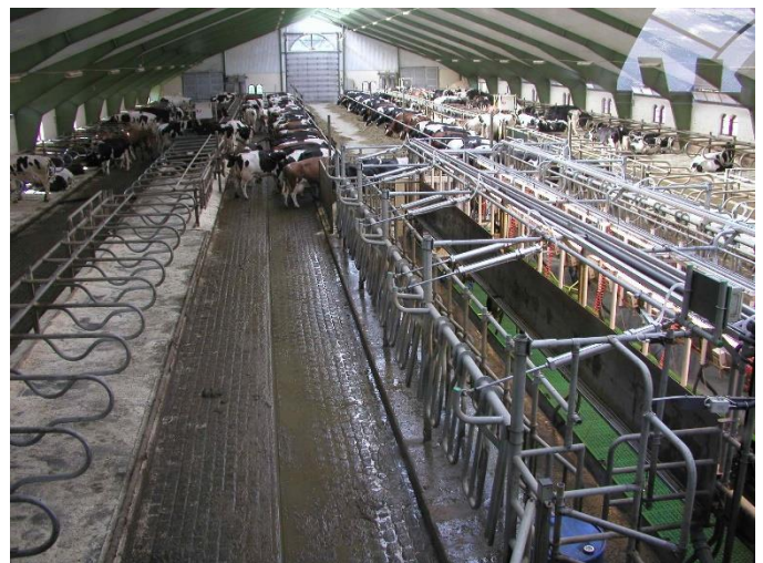
Abb. 4: Blick in einen Boxenlaufstall. Links befinden sich die Liegeboxen (mit einer Gummimattenauflage), in der Mitte der plan befestigte Laufgang, und rechts der Melkstand.
