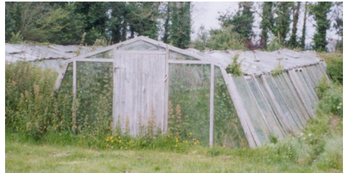
Altes Glashaus zusammengebaut aus Frühbeetfesntern, ©Arjen Huese
